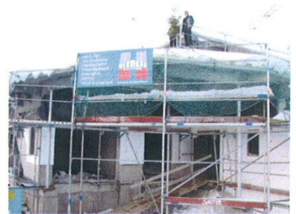
Hochbehälter Winterberg Richtfest am 6. Dezember 2008
