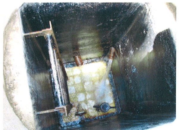
Quellschacht im Quellgebiet Rabenwald
