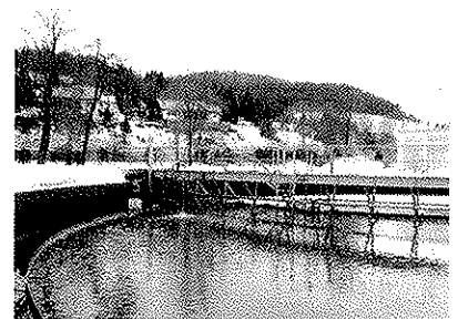
Absetzbecken auf der Kläranlage
