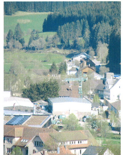
Kläranlage Blick vom Hochbehälter Winterberg
