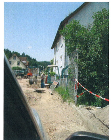
Baustelle in der Weiherstraße
