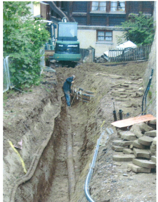
Arbeiten in der Unterallmendstraße
