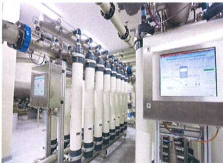
Ultrafiltrationsanlage
